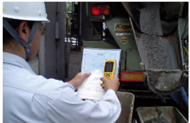
図 2.21 生コンクリート品質管理情報システムの利用シーン
